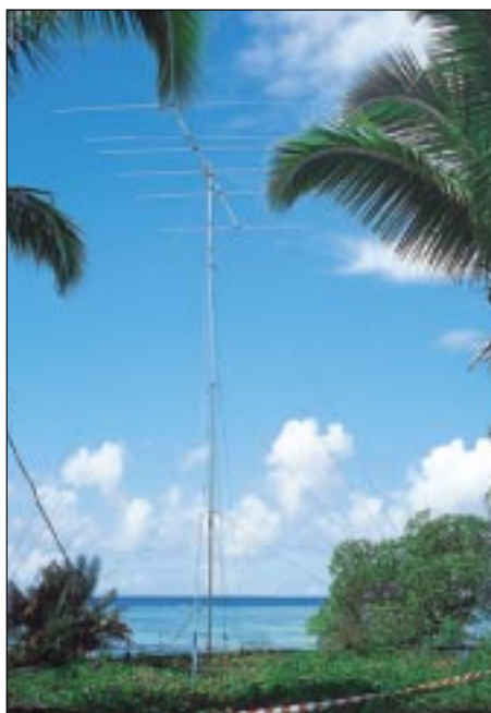
◀ Force 12, 6-Ele.-Yagi für 10 m, 12 m hoch in Richtung Europa, zur Sicherheit viermal abgespannt
