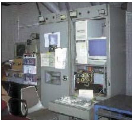
Der Digipeater Köln DB0WDR (438,225 MHz simplex, 1k2) in den Räumen von DK0WR .
